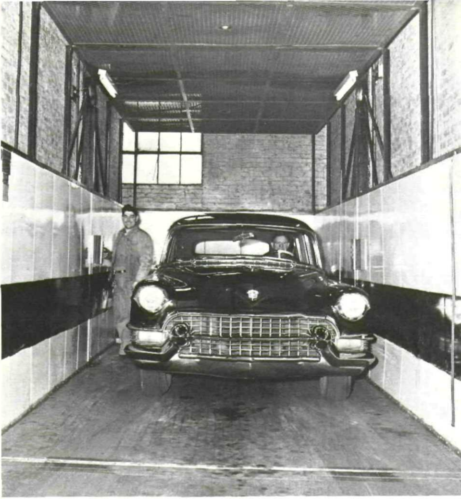
مصعد خاص للسيارات يستعمل في ورش التصليح الكبيرة ..
